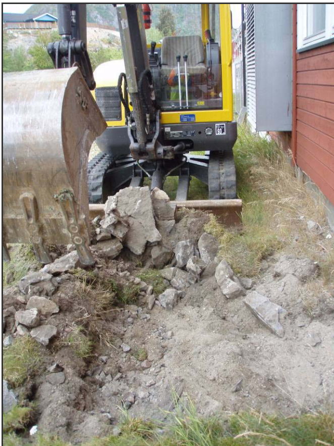
Bilde 4. PG.2 med betongfundament og blokk for bakfylling for støttemur.
